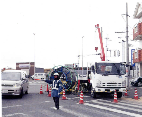
耐震化工事 施工時の状況（地上）
