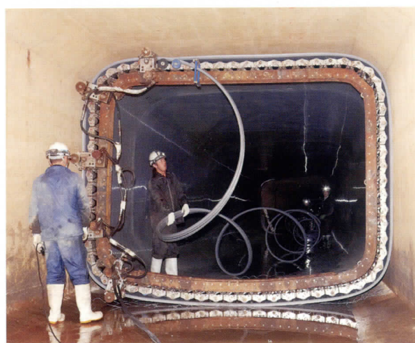
耐震化工事 施工時の状況（製管中）
