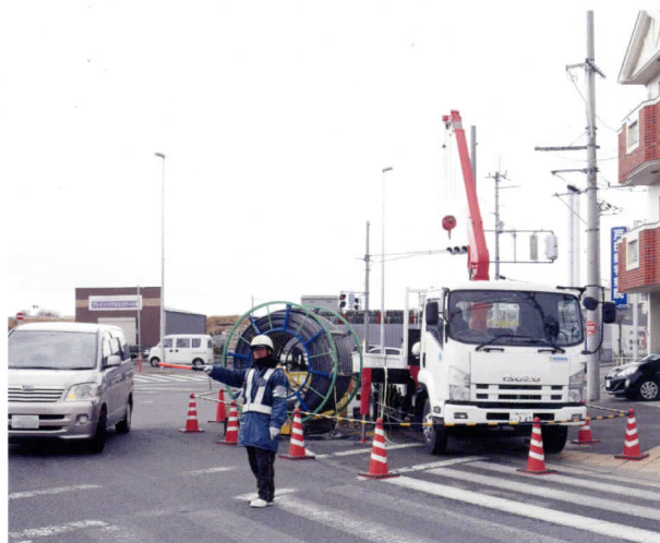
耐震化工事 施工時の状況(地上)
