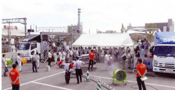
鹿児島市での製管デモ施工
