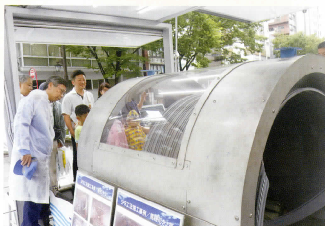
自由断面SPR工法の製管デモ施工をご覧になる小山局長
