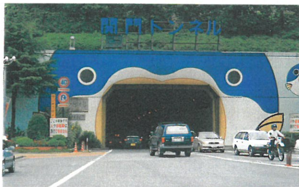
関門トンネル下関側入り口
