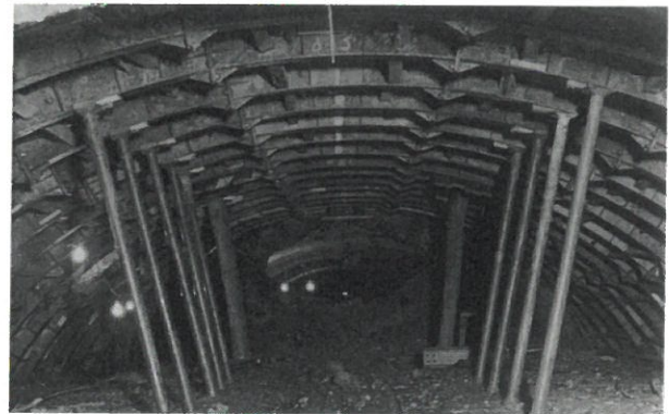
関門トンネル施工時の様子
