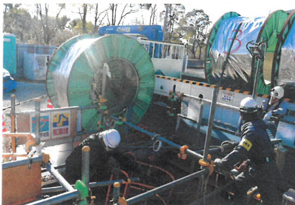
地上ヤードから更生材を送り込む
