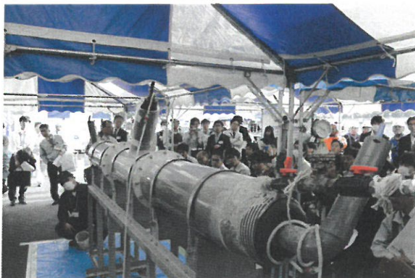
SPR工法裏込め剤注入工
