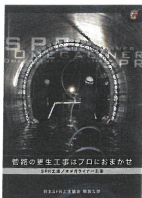
各種施工事例は冊子にもまとめ来場者に配布しました
