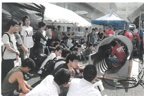
真剣なまなざしで施工を見学
