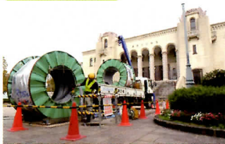
写真5-1 管更生工事(SPR工法)の現場見学会
