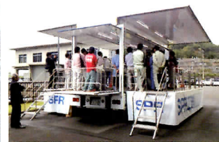
写真7-2 SPR工法、オメガライナー工法デモ施工(福山市)
