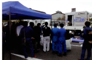
写真7-1 SPR工法、オメガライナー工法デモ施工(松江市)
