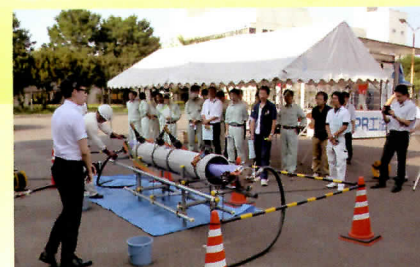
■姫路市下水道管理センター内
