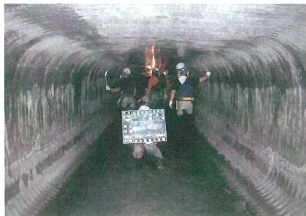
写真-1 管路内調査状況
