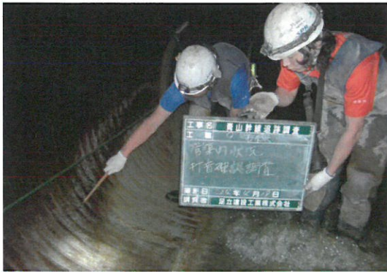
写真-2 管路内調査状況 (打音検査: 裏込め材充填確認)
