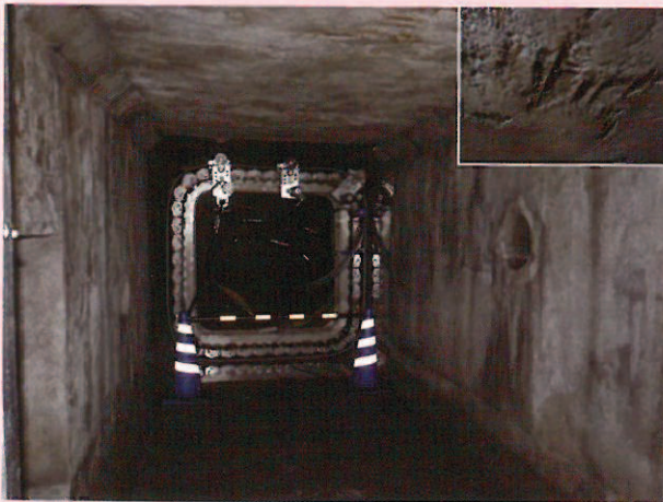
リアルな模擬管路内に設置した製管機
